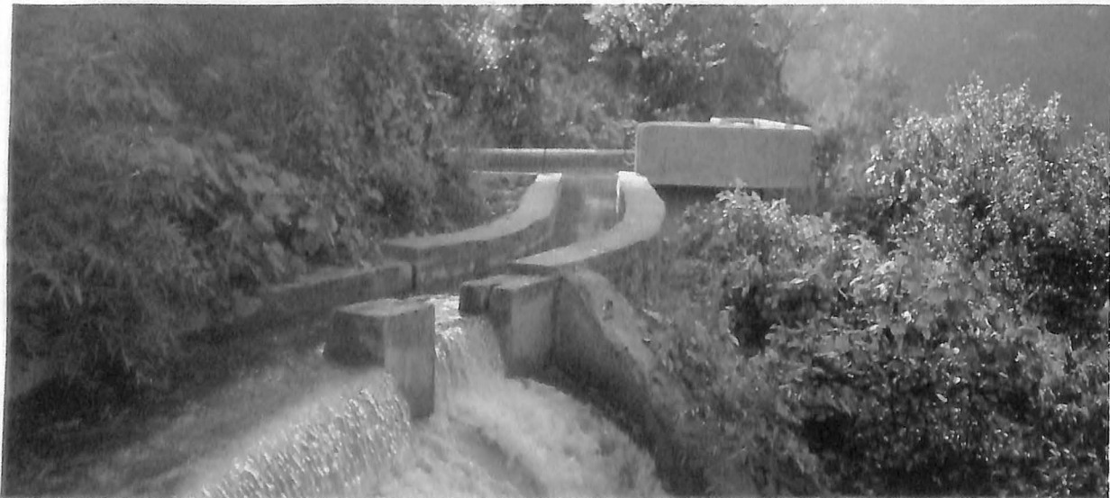
A 50 kW Mini Hydro plant at Bilkot, U.P.
