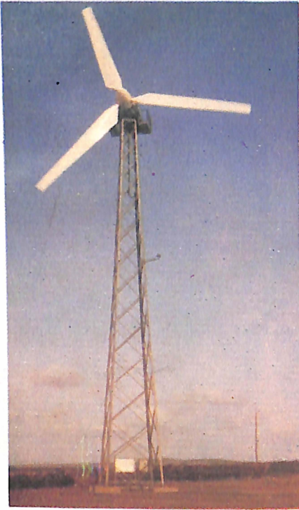
प्लेट 1. देवगढ़ संयंत्र में स्थापित 55 किलोवाट क्षमता की वेस्टास पवन टर्बाइन। इसमें तीन फलक, निश्चित गति, तथा स्तंभन नियंत्रित टर्बाइन है। रोटर का व्यास 16 मीटर तथा मीनार की ऊंचाई 23.4 मीटर है।
