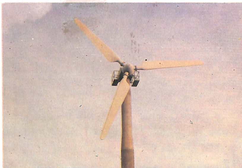
प्लोट 6. पवन ऊर्जा के अधिकतम उपयोग के लिए नये एरोफायल का प्रयोग इनकी दक्षता को बढ़ाता है।
