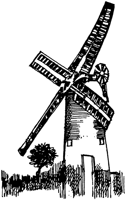
चित्र 12. सफाई स्थित एक मीनार चक्की। इसके पाल और पंखेनुमा पुच्छ साफ दिखाई दे रहे हैं।
